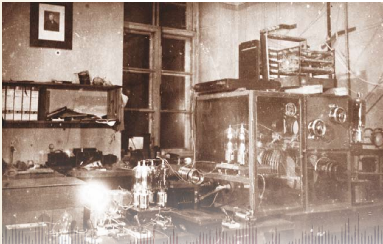
Передатчик с кварцевым возбудителем. Нижегородская радиолaborатория. 1925 год
