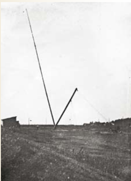
Установка антенны на радиополе
