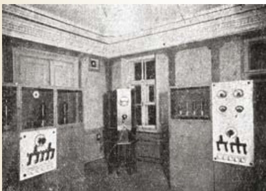
Расположение частей передатчика «Малый Коминтерн» на Воронежской станции
