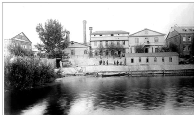
Здание электростанции на Нижегородской ярмарке. Вид со стороны Бетанкуровского канала
